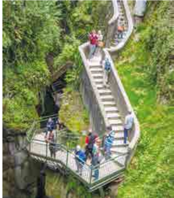
UNA DELLE PASSERELLE SULLE GOLE DELL'ORRIDO DI BELLANO
